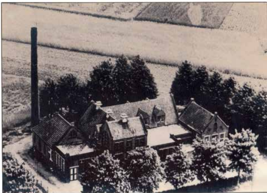
Stoomzuivelfabriek Sint Isidorus in Ravenstein, actief tussen 1917 en 1954.
